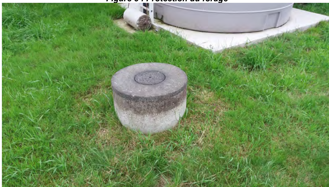
Figure 5 : Protection du forage
